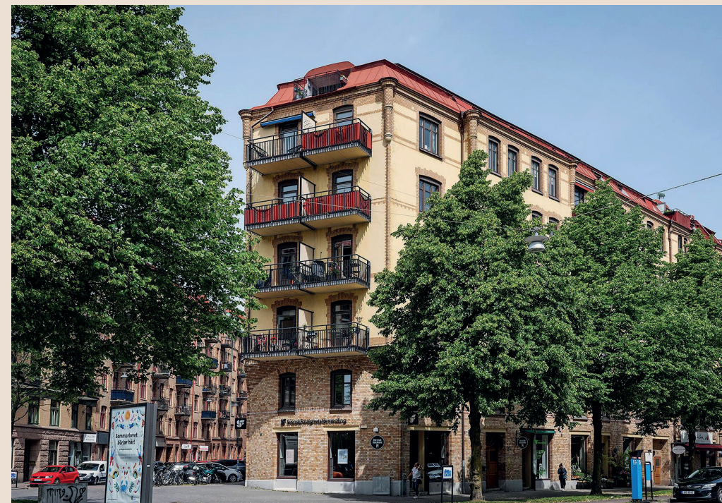
Kastellgatan 24 har en sockelvåning som sträcker sig över två plan vilket i skala relaterar till det större stadsrummet.
