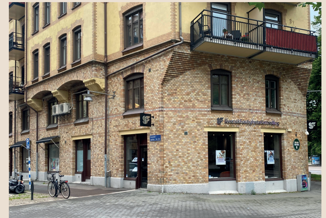
Avskiljandet av sockelvåningen förstärks av burspårk och balkonger från plan 3 på Kastellgatan 24.
