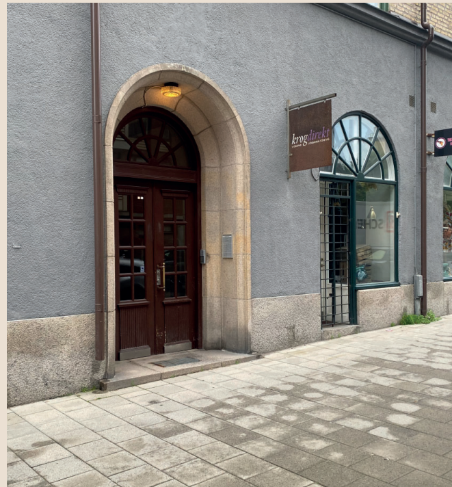
Indragen trapphusentré med stenomfattning
