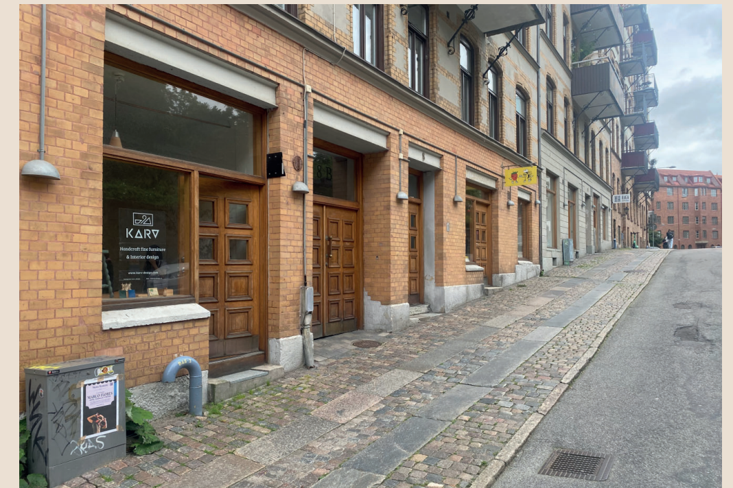
Lokalentré och skyltfönster med stålbalk i ovankant
