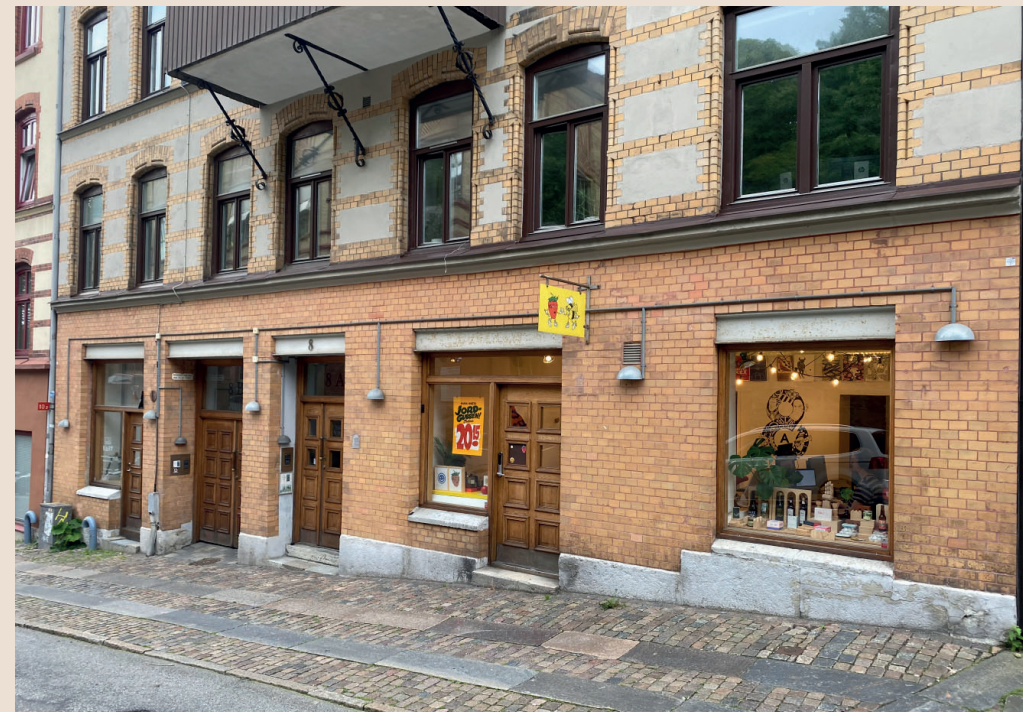
Trapphuset på Kastellgatan 8 markeras med ett större indrag än de två lokalerna. Sockelvåningen särskiljs med gesims och avvikande murning.
