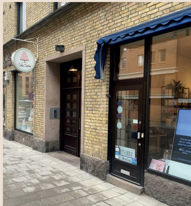
Indragen trapphusentré med stenomfattning Entré till lokaler placerade i liv med fönsterparti.
