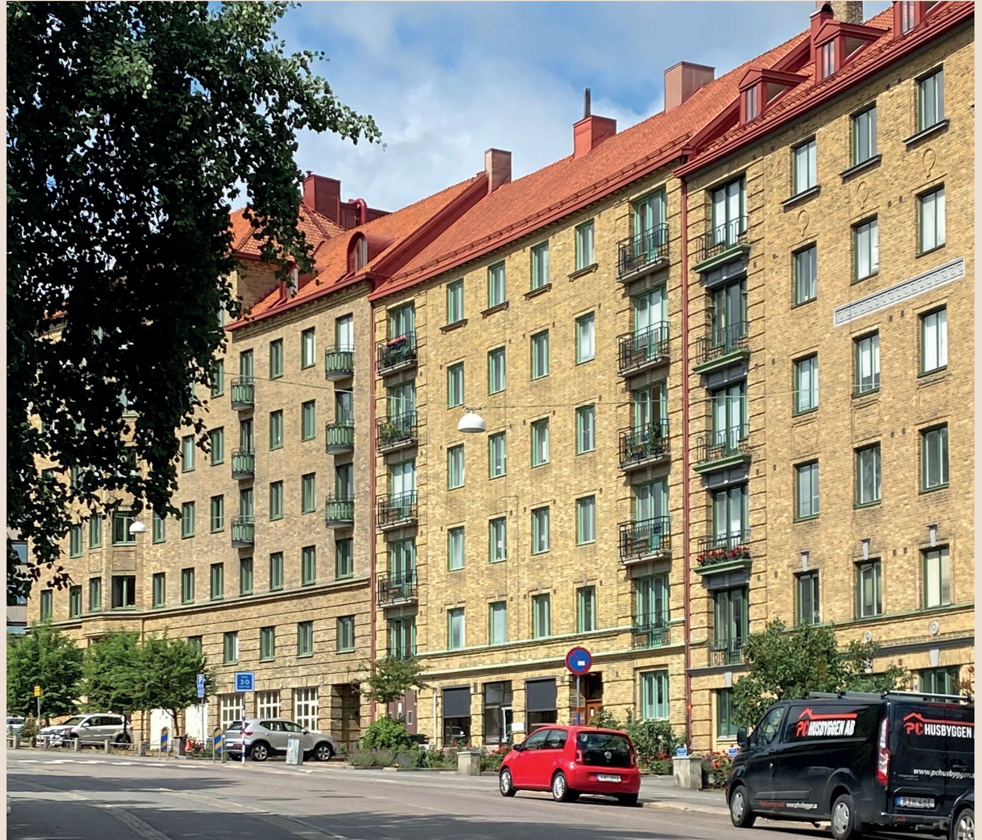
Byggnader inom kvarteret på Rosengatan.
