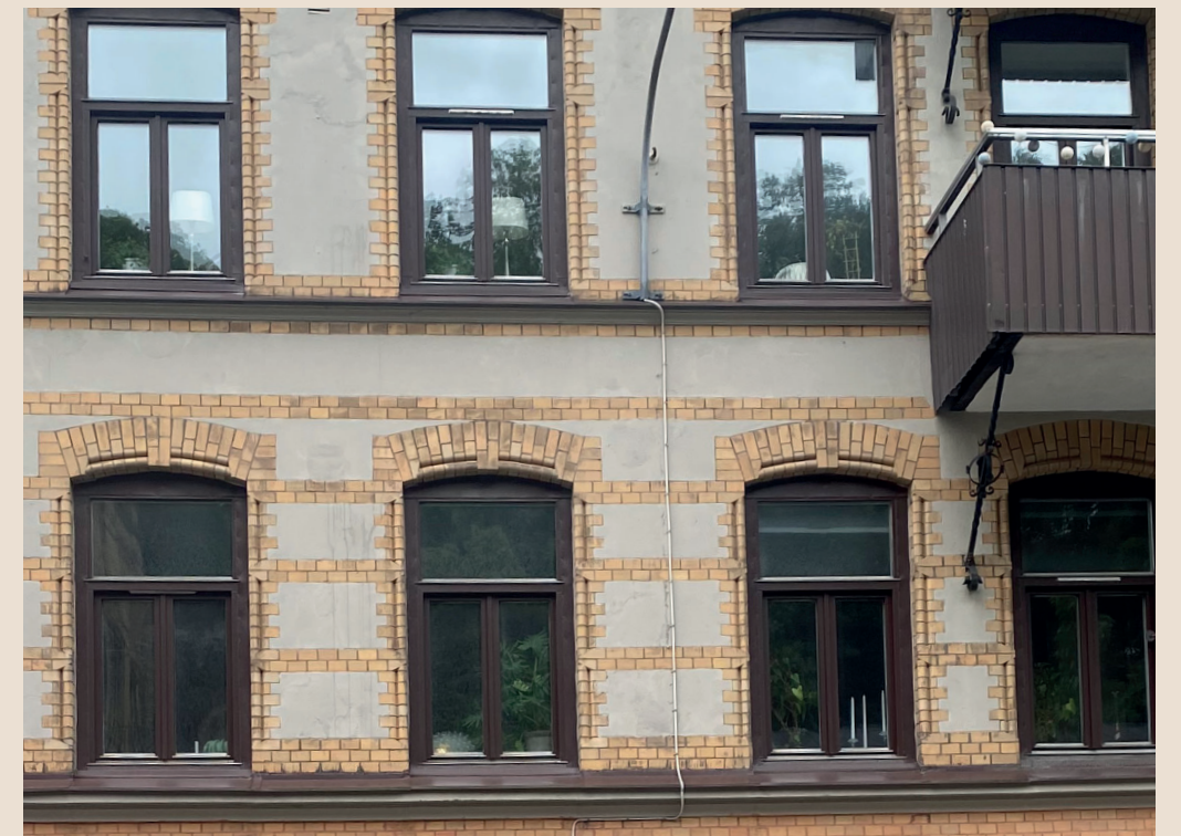
Tegelomfattningar kring fönster.
