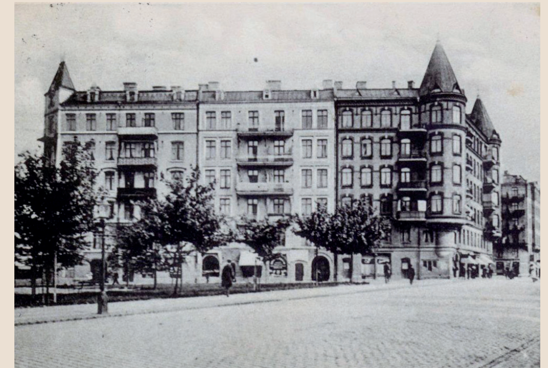
Fasader mot Sveaplan. Markerade hörn. Släta fasader förutom balkonger och torn över hörn.
