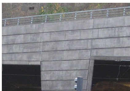
Matrisgjuten betong Chalmertunnelns mynning
