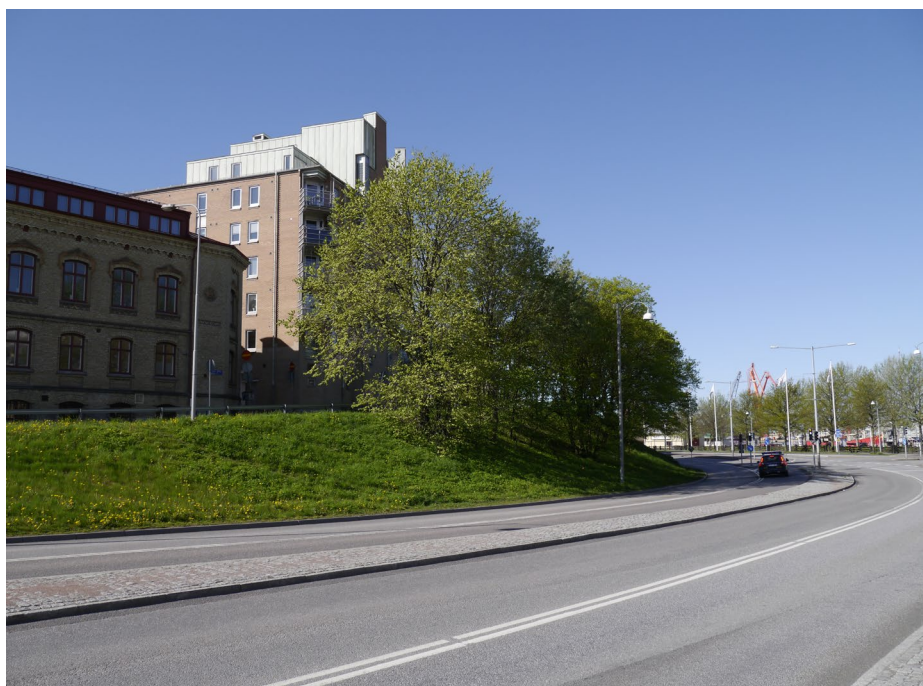
Platsen för serviceschaktet sedd från gatan nedanför.
