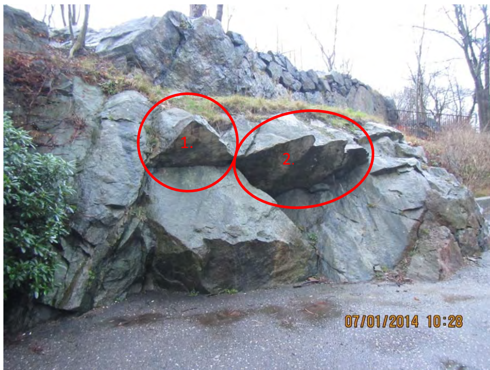
Figur 20, översikt nedre slänten med block 1 och 2.
