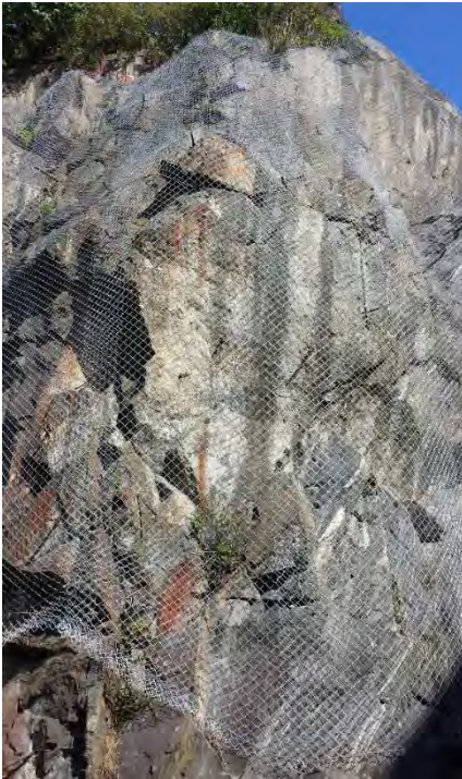
Figur 18, berget är förstärkt med bultar och nät.
