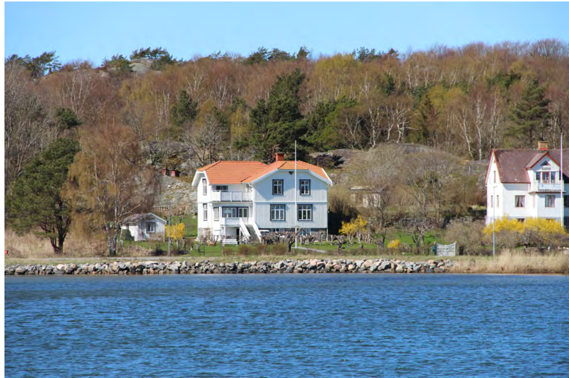
4. Bostadshus, 2 våningar. Stående ljus panel i fasad, tegelpannor på taket och granitsockel vid mark.
