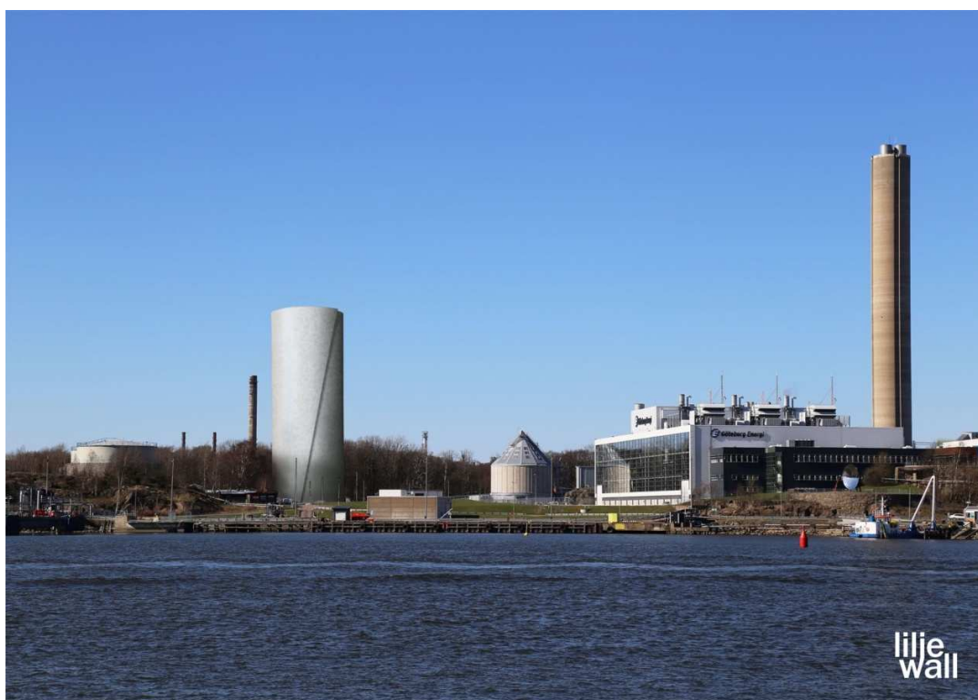
Fotomontage med ackumulatortanken till vänster i bild. Höger om tanken syns en lägre silo som är bränslelagringen och till höger Rya Kraftvärmeverk (Liljewall arkitekter).
