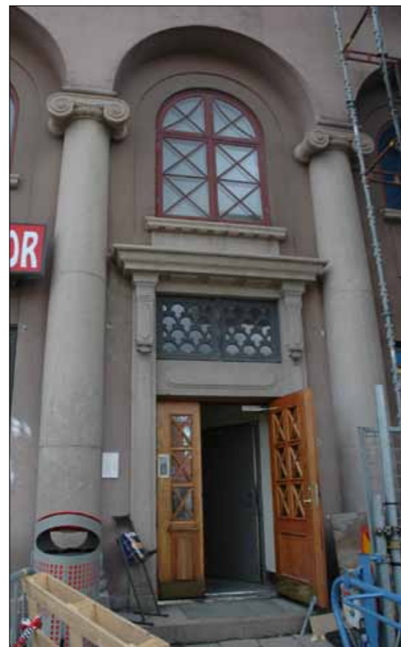
Entré till Järntorgsgatan 12 mellan kraftiga kolonner.
