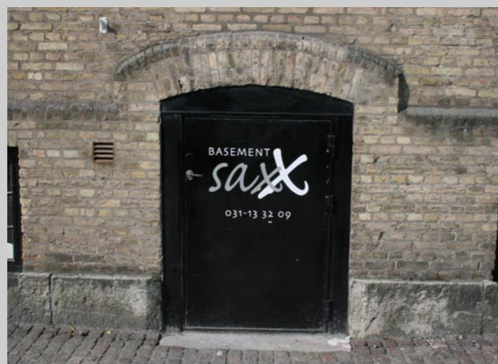
Källarentré med tegelskoning kring dörr..
