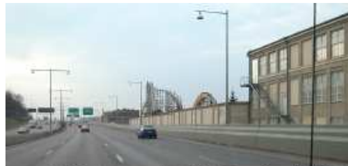
Mur för avskärmning av värmestrålning vid Liseberg. Fönster på byggnaden intill har i viss omfattning murats igen. Utmed trafikledens kant finns avkörningsskydd som är dimensionerat att stå emot tungt fordon så det inte ska kunna falla ner i området nedanför. Bild Enviro planning.
