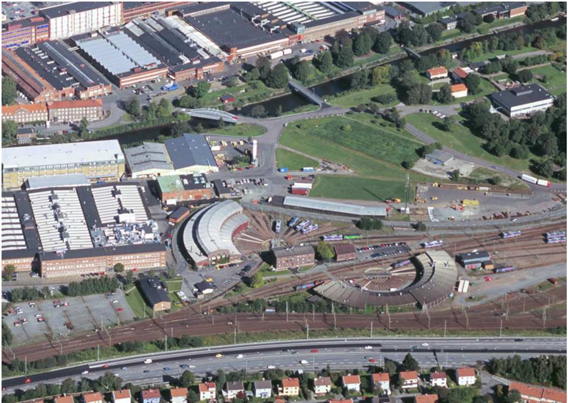
Lokstallarna utgör en byggnadsmässig tillgång för området mellan Säveån och E20. Foto: Flygare Palmnäs 2004
