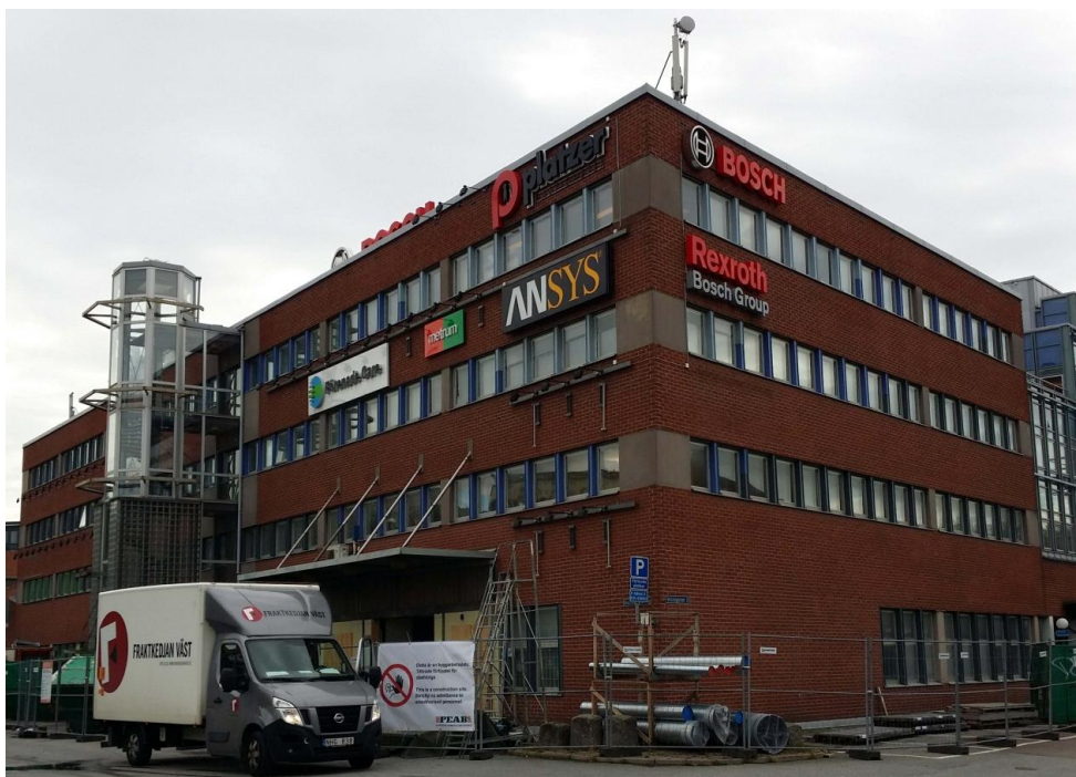
Befintlig bebyggelse på fastigheten Gårda 1:15. Bilden tagen från nordväst.
