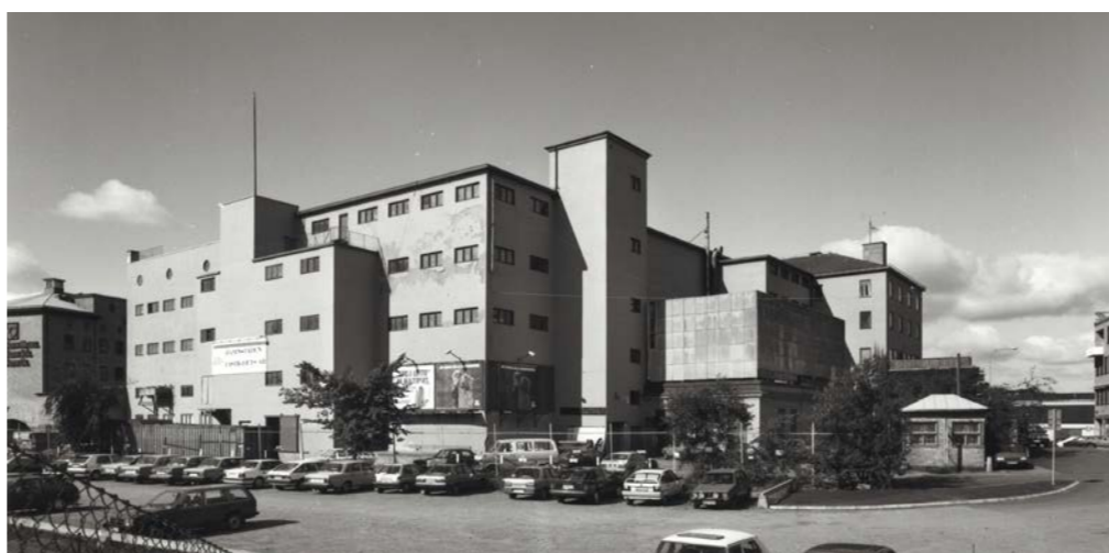
Fryshuset modell 1940-tal, foto 1987 från sydöst. I nuvarande bilverstaden syns klassicistiska former, plåtöverbyggnaden är kvar. Hisstornet bakom är påbyggt men i samma läge, L-formen och gårdens form går att avläsa. Jämför med översta bilden på motstående sida som visar samma vinkel idag.
