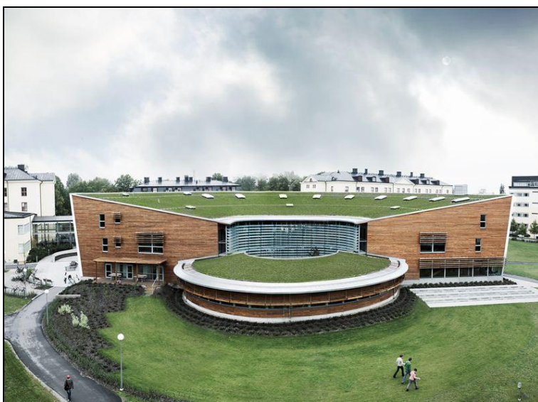
Figur 3. Byggnad med grönt tak. Källa: Vegtech
