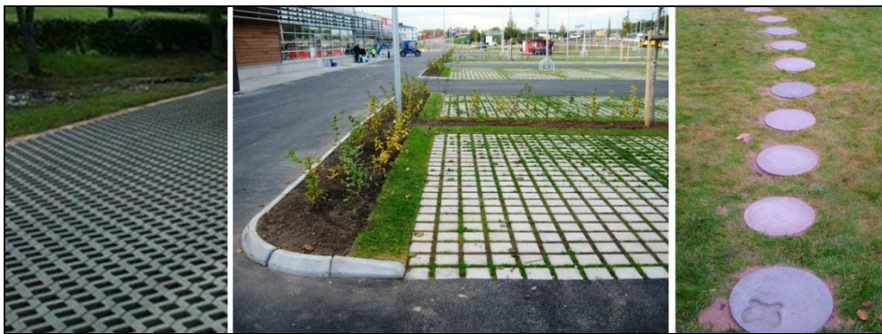
Figur 2. Ytor med hålsten av betong samt gångstig med gräs och gångplattor
