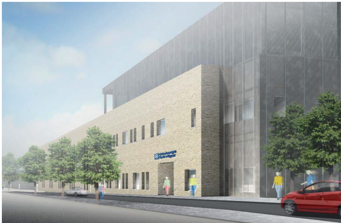
Verkstadsbyggnaden med huvudentré (BBH arkitekter & ingenjörer, 2016).
