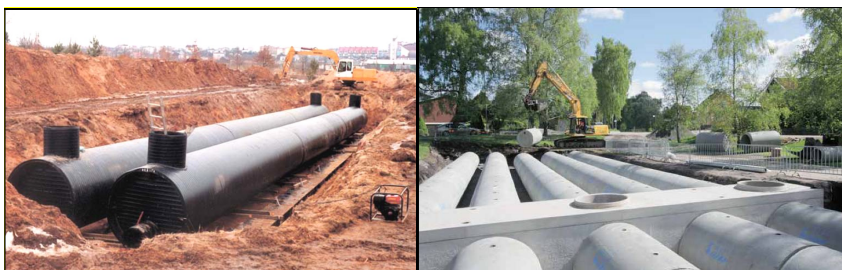
Figur 9. Exempel på utjämningsmagasin bestående av två rör av typen KWH-pipe alternativt rörpaket i betong av typ Alfarör.
