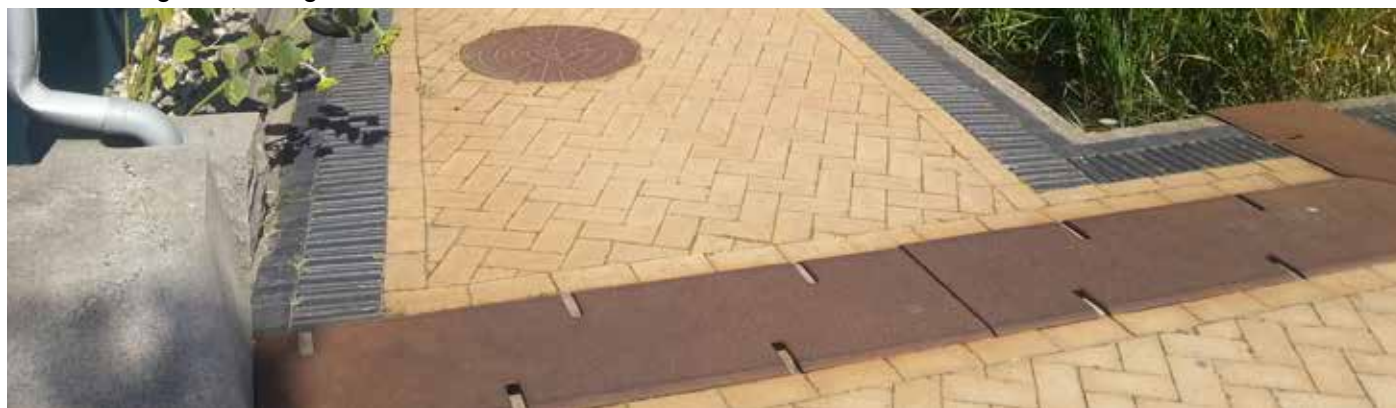
Exempel från Malmö på övertäckning av ränna som leder dagvatten från stuprör till vegetationsyta.
