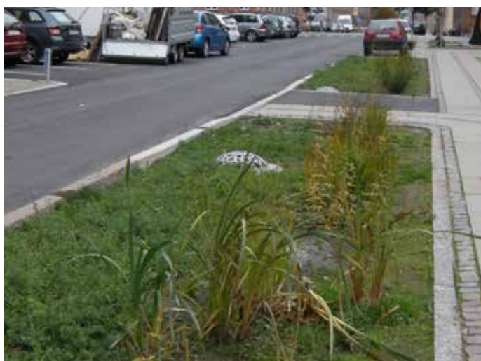
Gata i Köpenhamn med smal grönremsa som tar hand om dagvatten. Bilden visar exempel på kantstöd med släpp, designad kupsil till dagvattenbrunn men också svårigheter med att etablera vegetation i den här typen av blå-gröna stråk.
