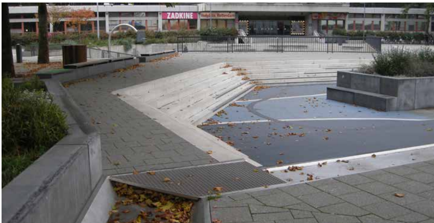
Vegetationen är en del av dagvattenfördröjningen på ett torg i Rotterdam, men de stora vattenmängderna samlas i de hårdgjorda lekytorna. I förgrunden på bilden ser vi exempel på en dagvattenränna med övertäckning.
