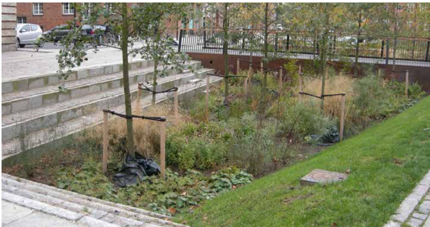
En stadsdel i Köpenhamn har klimatsäkrats för att klara skyfall. Nedsänkta grönytor som den på fotot ska ta hand om och fördröja stora volymer vatten vid kraftiga regn, och fungera som små parker resten av tiden. Den här typen av småskaliga lösningar till exempel i korsningar och vid indragningar av byggnader kvarteren kan passa in i stadsstrukturen i Frihamnen.
