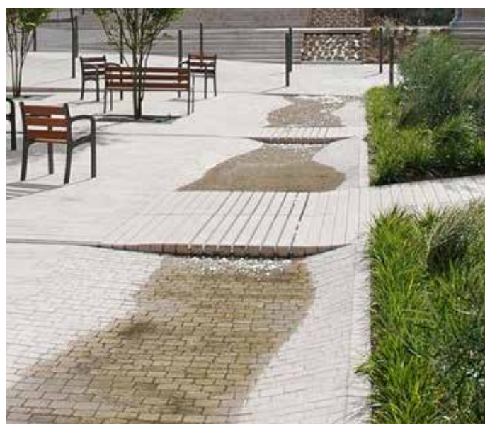
Grund svacka i plattytta som leder dagvatten till vegetationsyta för rening. Foto: SBK
