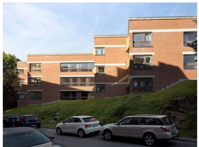
Bef. Humansten föreslås kompletteras med byggnader där det i dag är inbyggda övergångar mellan flyglar. Vy från Lundgrensgatan, skiss(Kub Arkitekter 2012).
