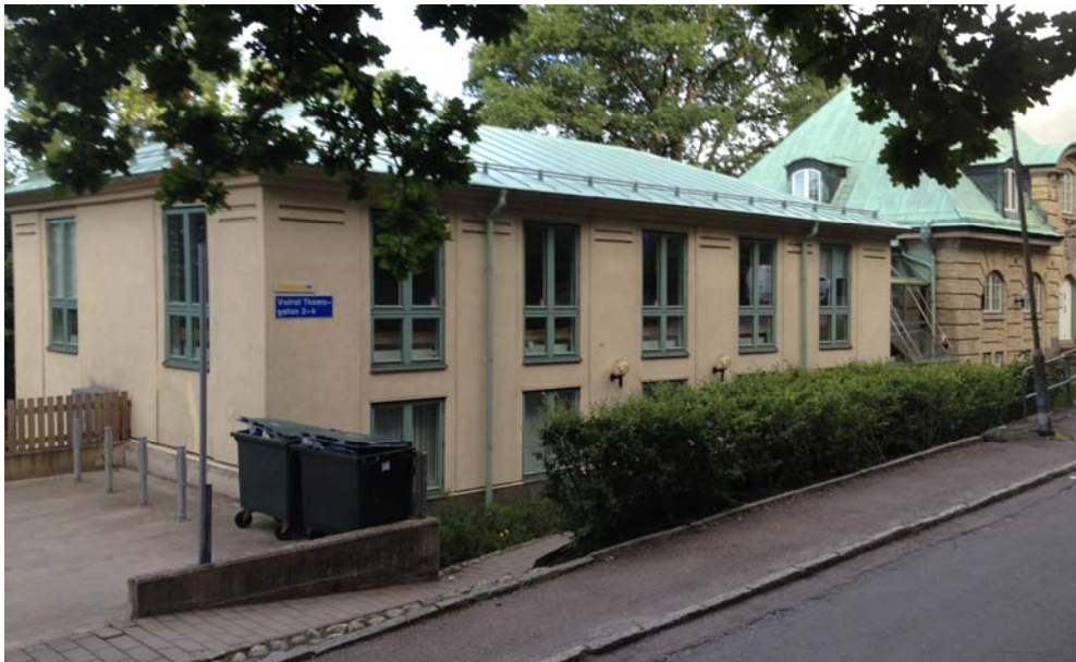
Den före detta pumpstationens tillbyggnad från 1985 (Foto J Henrikson).
