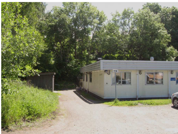
Befintlig förskola är en enkel byggnad.
