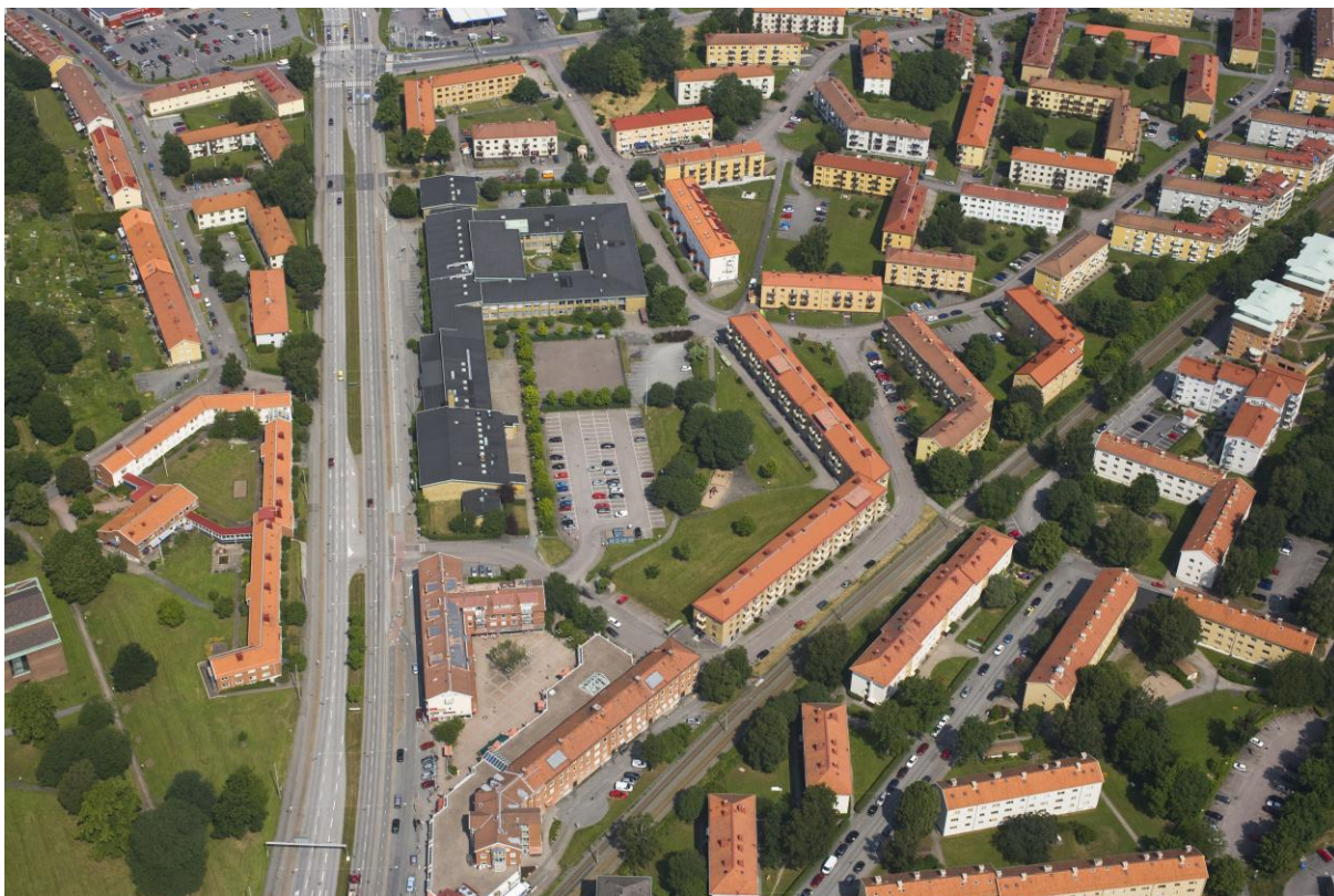
Området sett söderifrån. Skolbyggnaden är nu riven
