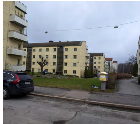
11. Vy in i lamellhusområdet
