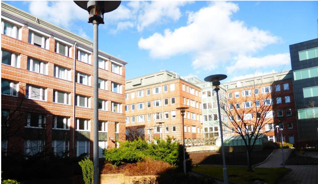
Byggnaderna inom Gårda 18:19 och 18:22 sedda från gården
