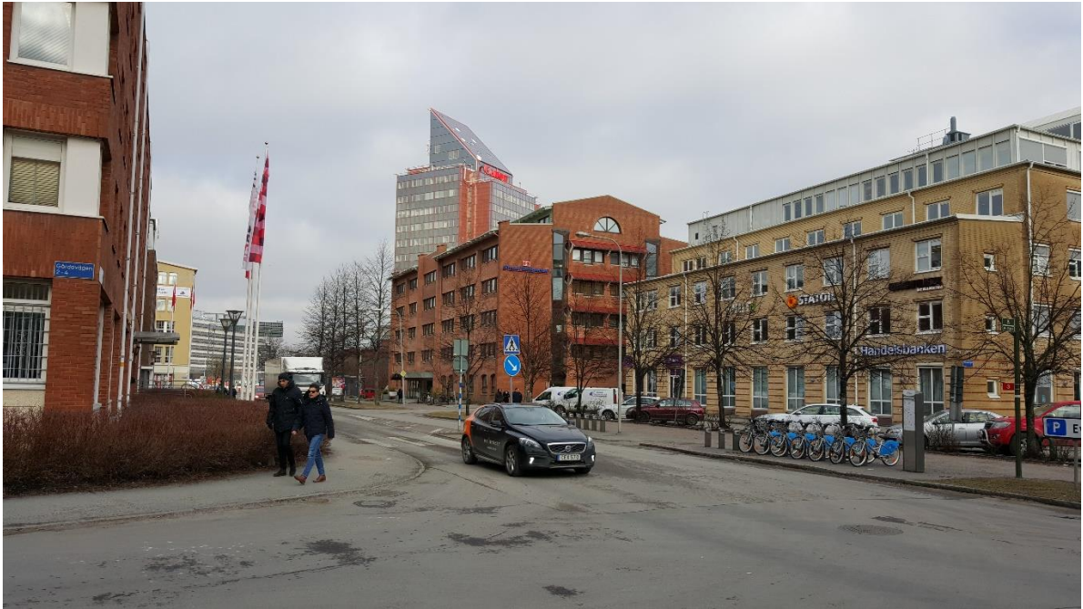
Figur 15: Fabriksgatan norrut från korsningen med Gårdavägen. Asfalt och marksten dominerar som beläggning, medan inslaget av grönytor är begränsat. Medelstora gatuträd finns längs hela Fabriksgatan. Foto: CEC Design (februari 2016).
