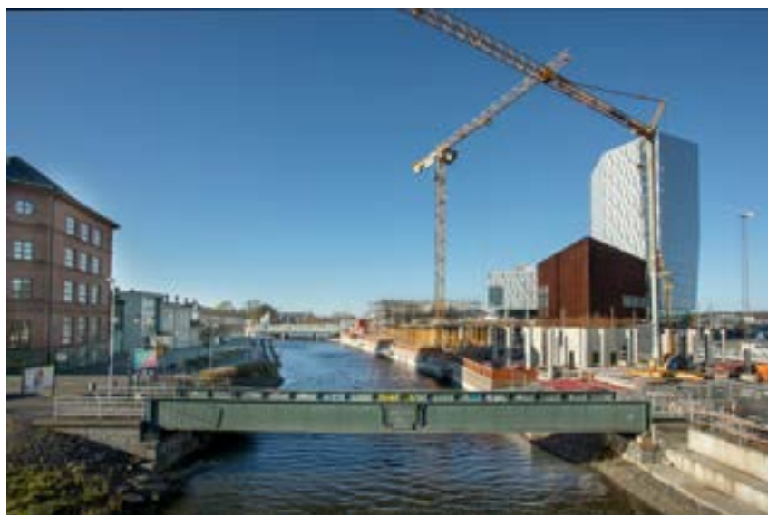
Säveån och byggnationen av Gamlestadens resecentrum. Foto Marie Ullnert
