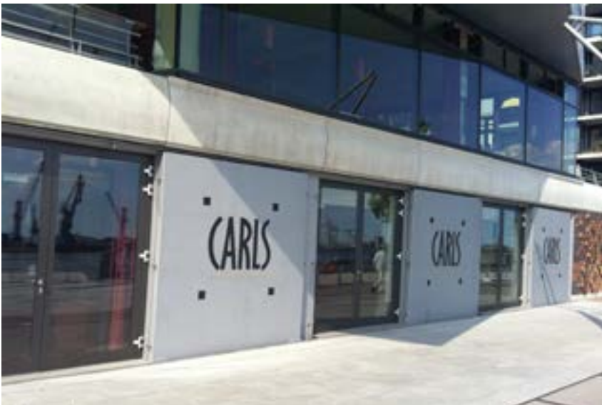
Skydd av restaurang med luckor som kan stängas vid högvattenvarning, Hamburg/Hafen City. Foto Ulf Moback.
