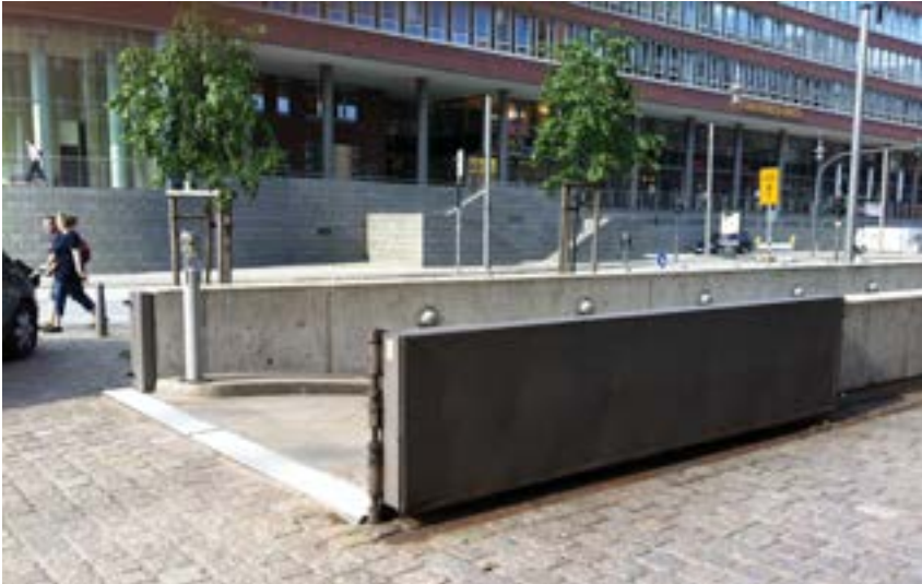
Skydd av underjordiskt P-garage, Hamburg/Hafen City. Foto Ulf Moback.
